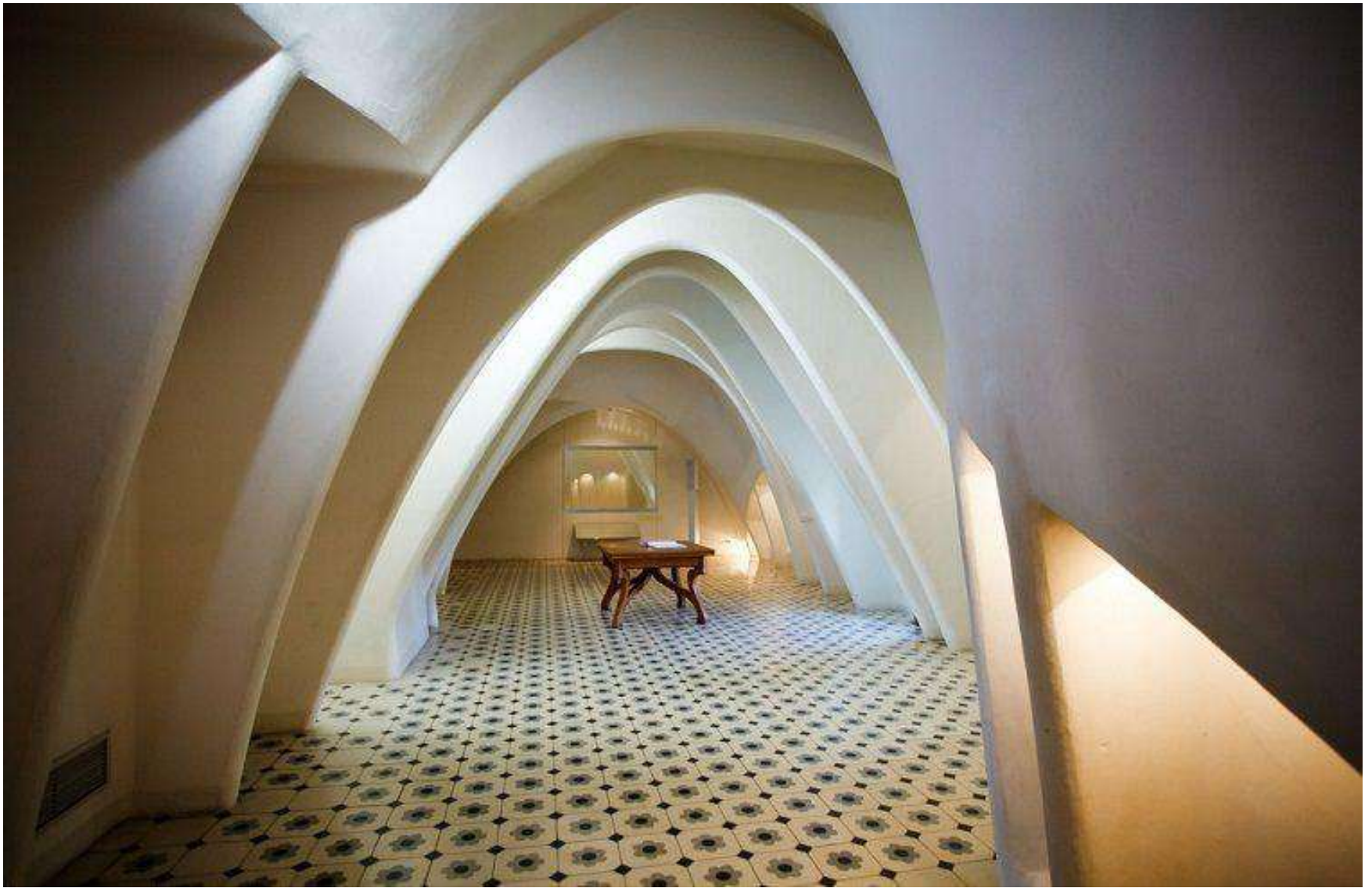
Interno della mansarda caratterizzata da archi catenari
